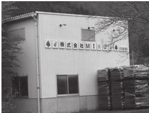
揖西町の事務所外観
