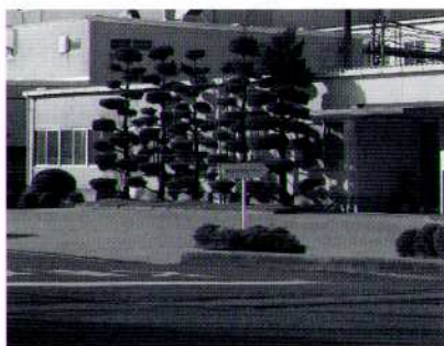
遮熱塗料を塗布された 事務所入口前のアスファルト
