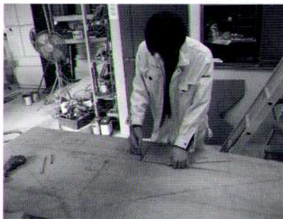
設計図から全体の調和を図るために板に下書きされる様子
